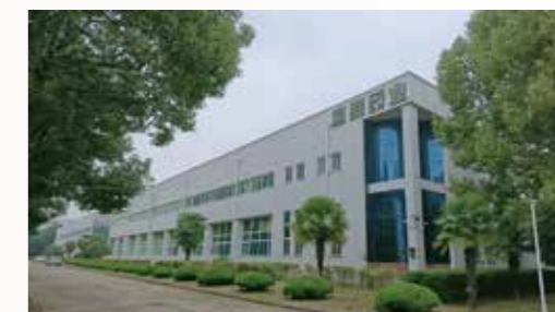
国森药业厂区内部情况
